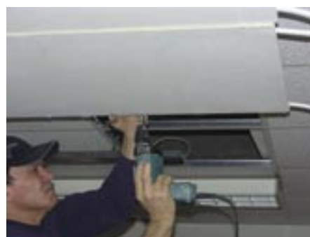
Montáž chladiaceho panelu
