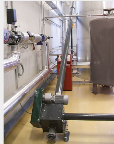
Obr.: Doprava popola z 2 kotlov HERZ pomocou šikmého závitového dopravníka do zásobníka popola s objemom 2 m 3 umiestneného mimo kotolne s prekonaním výškového rozdielu viac ako 4m.
