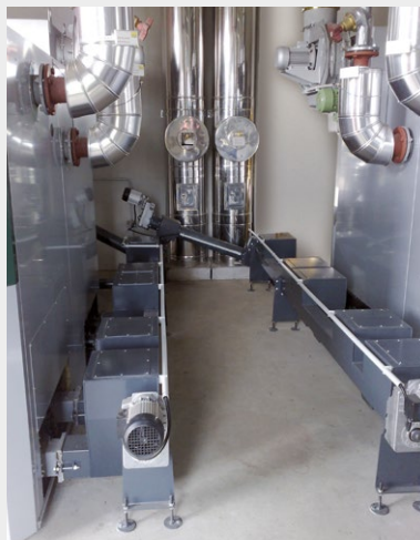
Obr.: Prepojenie zásobníkov popola systémom závitoviek v kaskádovom riešení
