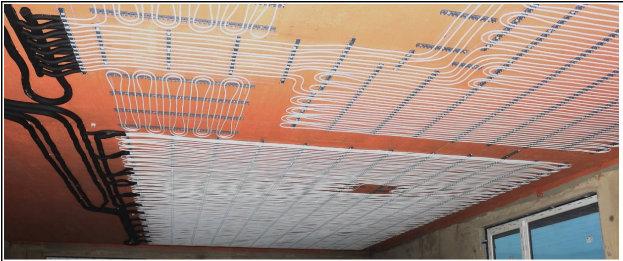
3. Montáž rohoží - detail
