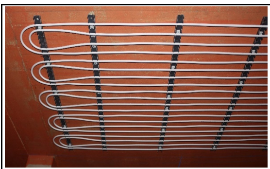
3. Montáž rohoží - detail
